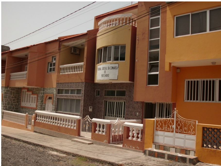
Fig. 6.7.2- Instalações do Tribunal Judicial da Comarca de Porto Novo
