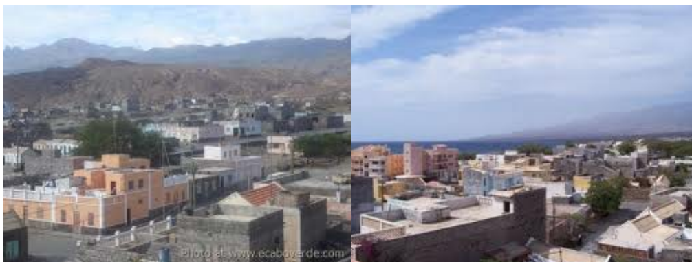
Fig. 5.1.3 - Tipologias do Edificado dominante na Cidade do Porto Novo
