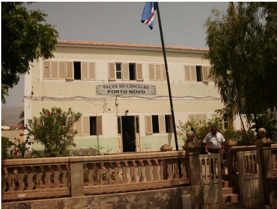
Fig. 8.7.1- Antigas Instalações da Câmara Municipal
